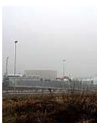
L'impianto a biomasse, D.M.
